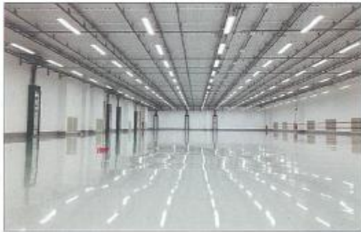
Les deux salles informatiques, chacune d'une surface de 1000 m 2 , sont rafraîchies par le faux-plafond.
