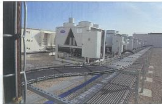
Le rafraîchissement se fait en priorité par free cooling et par des groupes à détente directe.
