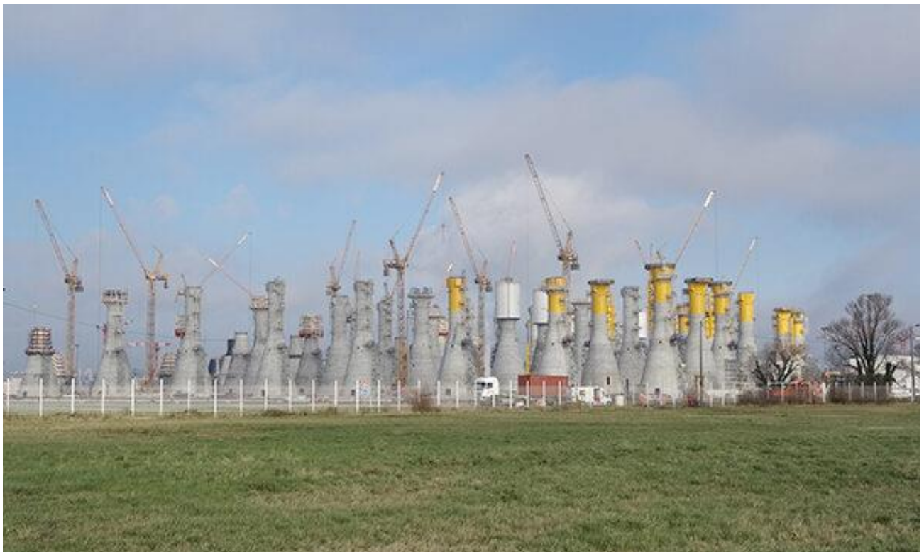
Construction des fondations gravitaires des futures éoliennes à proximité de l'usine de Siemens Gamesa en février 2022. © Jgp
